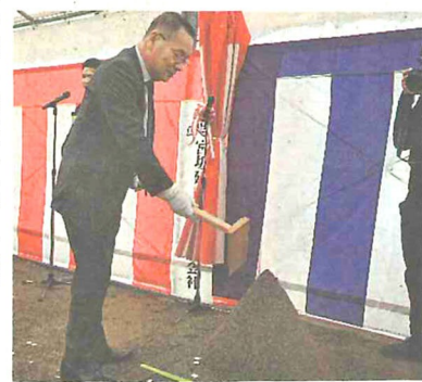
地鎮祭でくわ入れを行う今津会長
